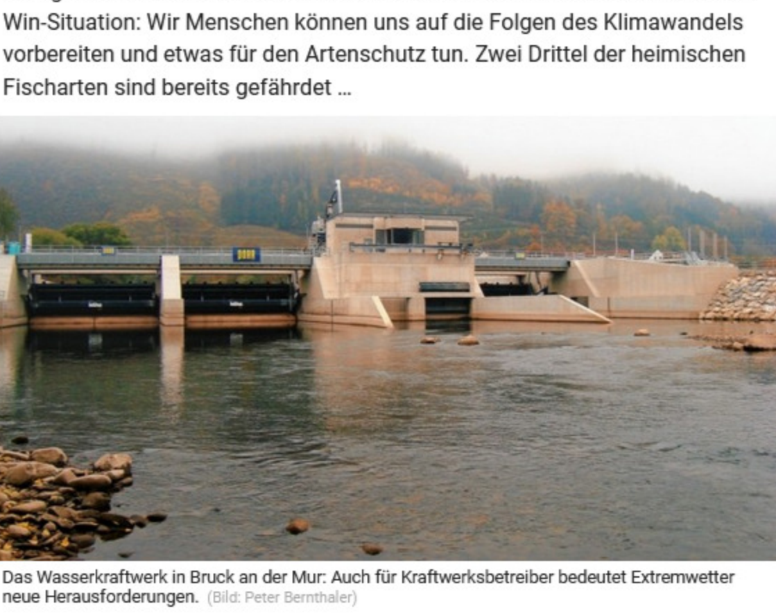
Das Wasserkraftwerk in Bruck an der Mur: Auch für Kraftwerksbetreiber bedeutet Extremwetter neue Herausforderungen. (Bild: Peter Bernthaler)
